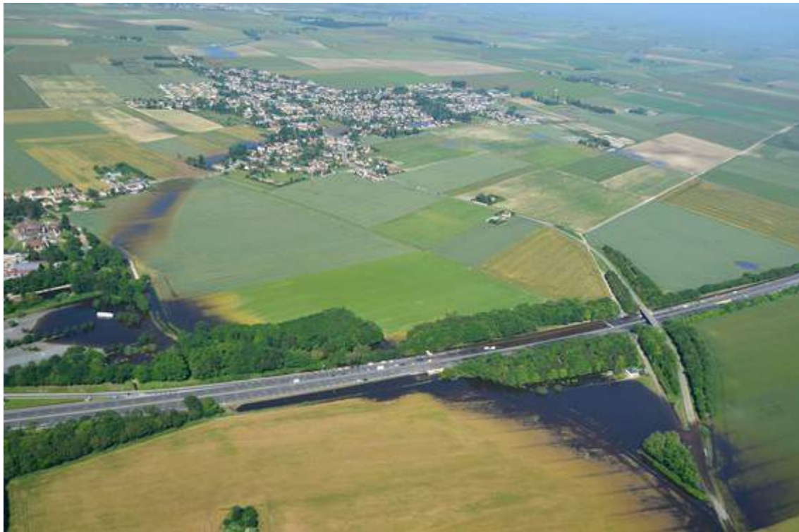
Figure n° 12 – Inondations à Gidy, 9 juin 15h21, Source BRGM
