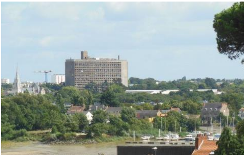
Figure 13. Maison Radieuse de Rezé (Creative Commons - Wikipédia/Jibi44)
